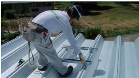
②設置箇所は、親網システム用支柱の使用基準（表1及び図1）に従って計測して位置決めする。
