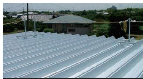
⑧親網を取付け、緊張器を用いて、概ね水平になるように緊張して完成。
