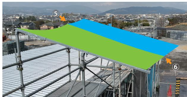
④外側フックに、隣り合わせの養生シートの隅部のハトメを2枚合わせて引掛けます。
