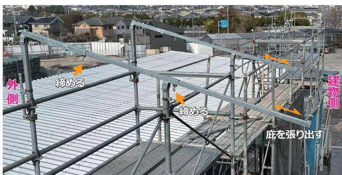
③底を建物側に張り出す、フレーム固定ネジを締めます。
