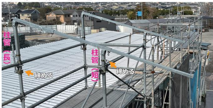
②柱管(長)と柱管(短)を足場部材に差し込み、柱固定ボルトを締めます。
