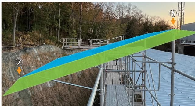
⑥外側フックに、隣り合わせの養生シートの隅部のハトメを2枚合わせて引掛けます。
