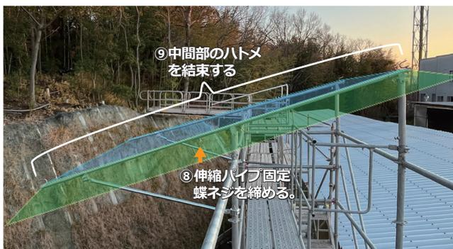
⑧伸縮パイプを伸ばし養生シートを緊張させ、伸縮パイプ固定蝶ネジを締めます。
