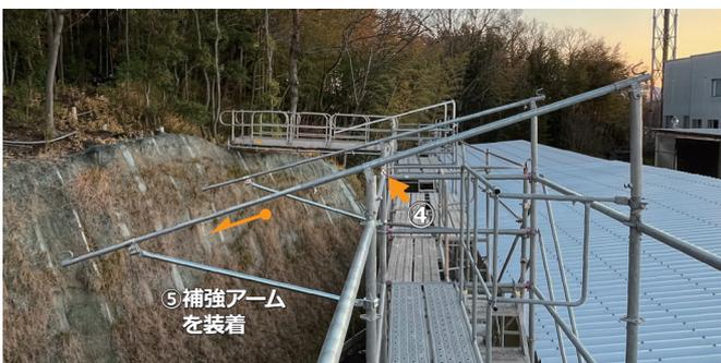
④フレーム固定金具の蝶ネジを締めます。
