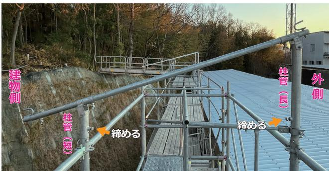
③柱管(長)と柱管(短)を足場部材に差し込み、柱固定ボルトを締めます。
