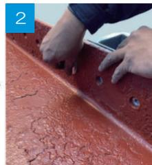
2 山留鋼材の内側からボルトでホルダーを固定します。ラチェット、インパクトで締め付けます。
