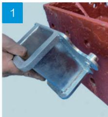
1 ホルダーを山留鋼材のボルト孔へ差し込みます。
